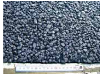
電気炉スラグ骨材を使用した排水性舗装事例
