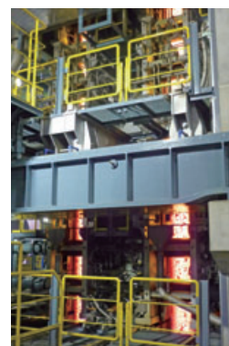
60トン連続鋳造設備
