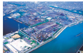
本社・工場全景
