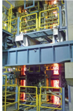
60トン連続鋳造設備
