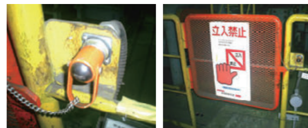
安全装置(左)・安全柵(右)の設置
