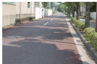
当社のスラグ製品を使用した姫路市内の資源循環型舗装道路
