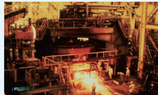
150トン電気炉(1982年)
