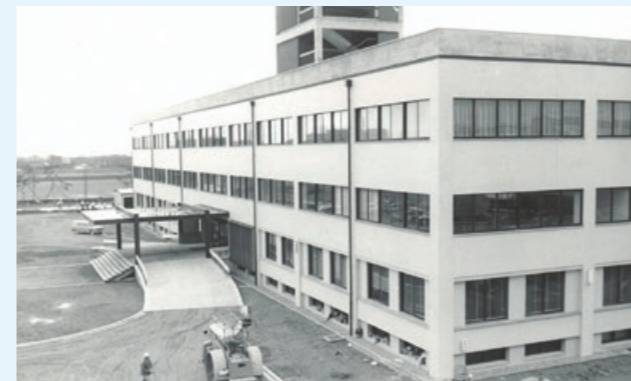
新社屋(現 本社事務所)建設(1964年)
