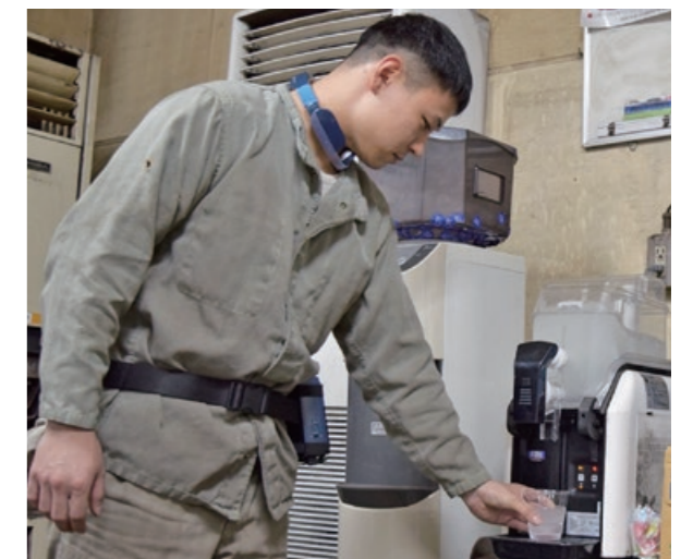
アイススラリー製造機の設置
