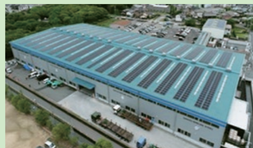
製品倉庫屋上の太陽光発電設備
