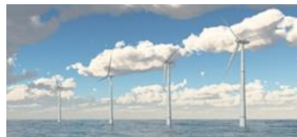
【風力発電設備外観】
