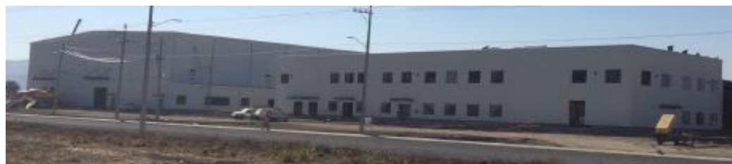
<工場建設中の様子>
