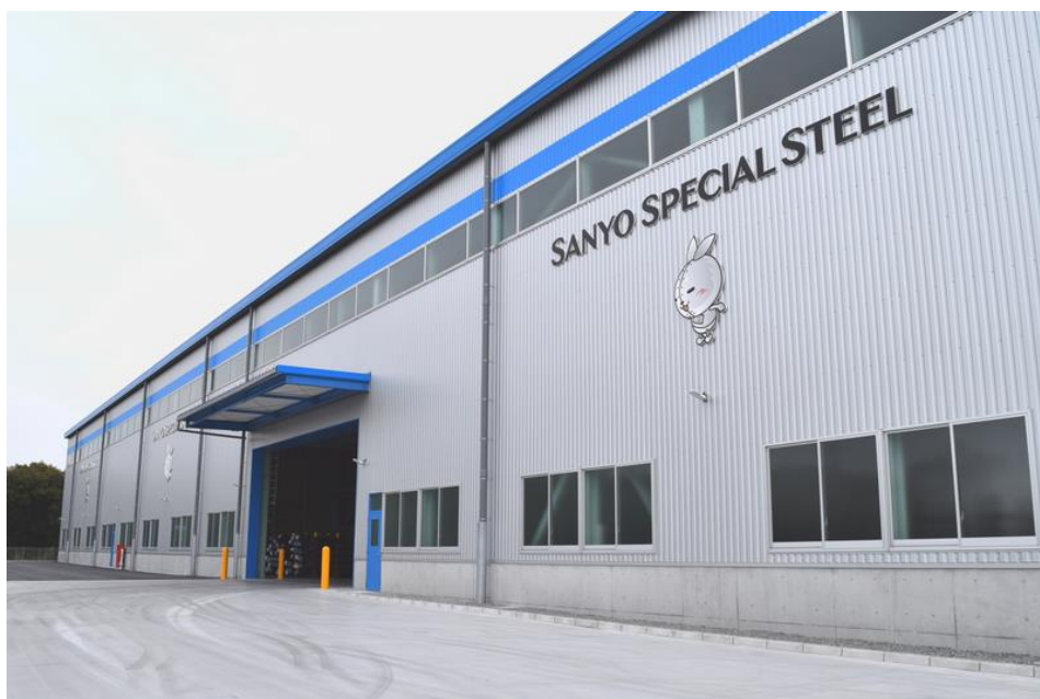
■太陽光発電設備を設置する製品倉庫
