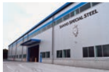
新製品倉庫の外観
