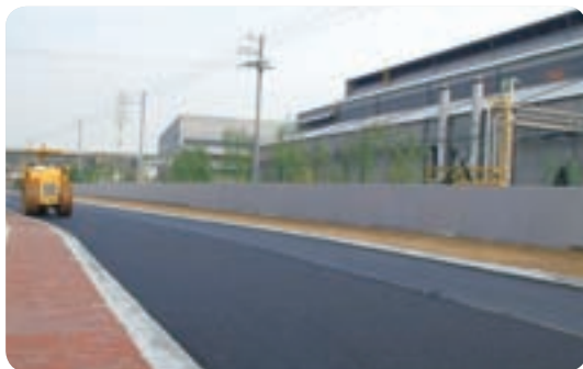
工場内の道路にも、電気炉スラグ製品を活用しています。
