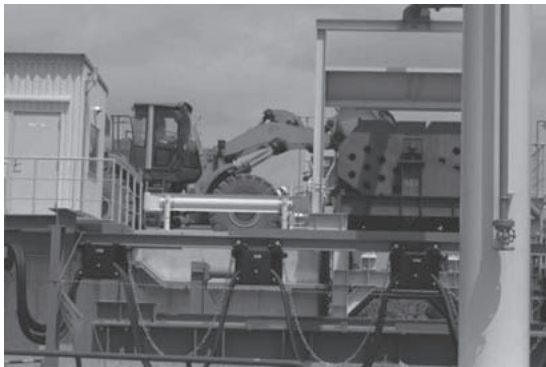
図4. 処理前スラグの積み込み作業
